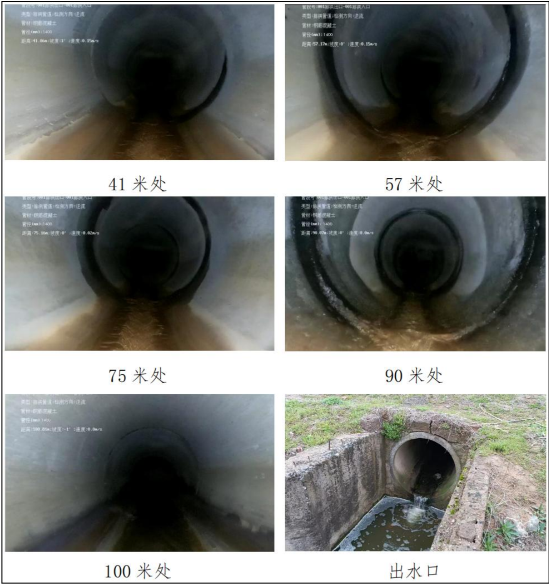
图 5.2-2 排洪系统涵管（隐蔽部分）影像资料
