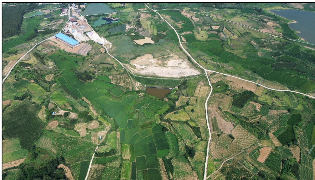
图 2-2 尾矿库库区航拍图
